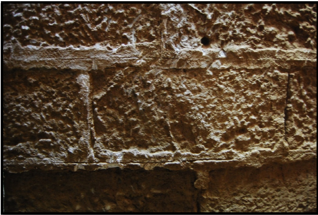
Foto 4. Detall del parament de la torre UE 101.
