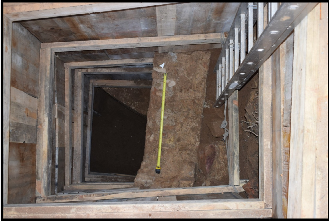
Foto 2. Vista del fonament UE 100. Per sota torre UE 101.
